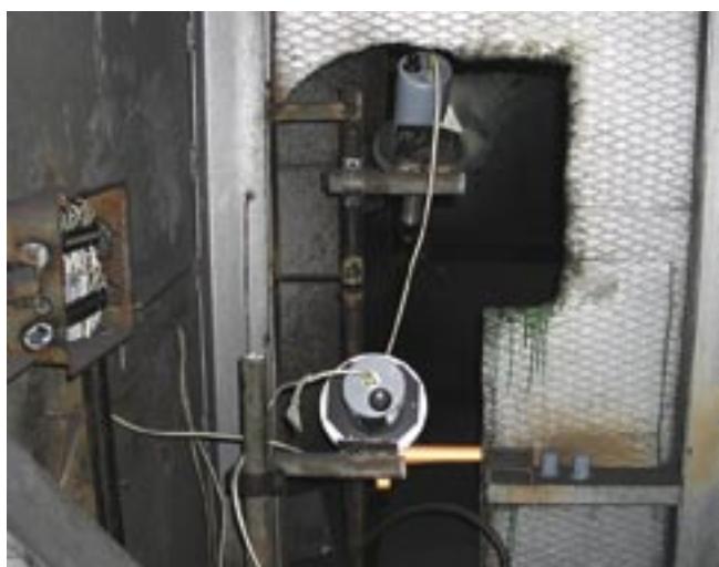
Термоскоп-004. Сортопрокатный стан. Участок термоупрочнения
